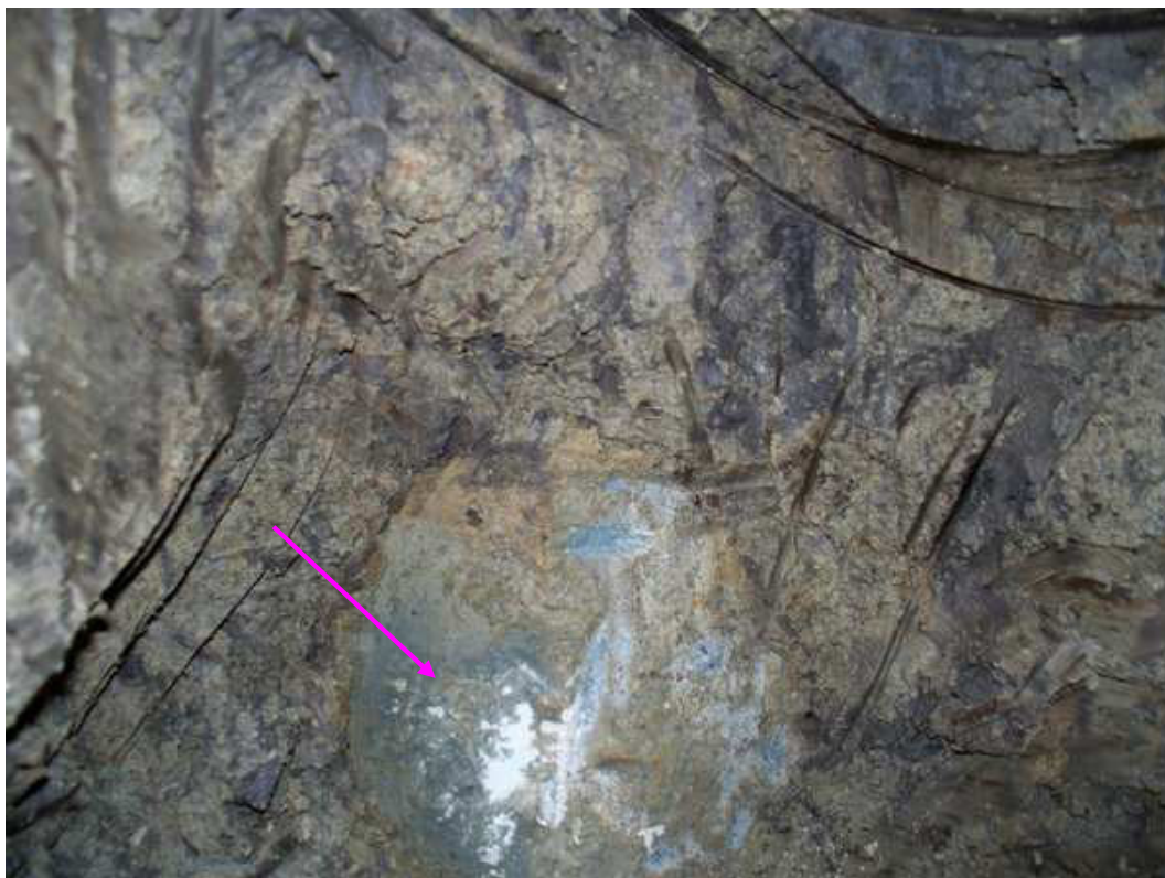
Obr. č. 5 – pohled na zastiženou mikropilotu s patrnou kvalitou zálivky
