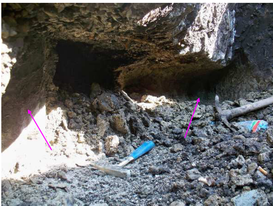
Obr. č. 6 – celkový pohled do podzákladí zdi se dvěma mikropilotami
