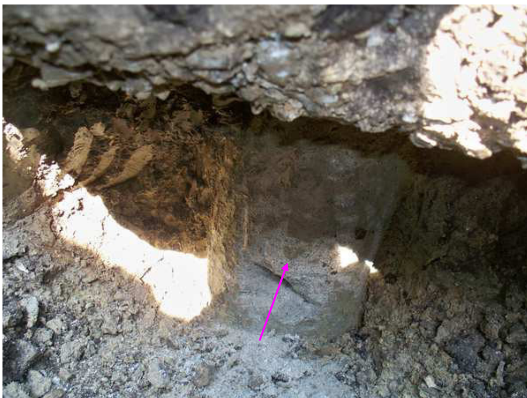
Obr. č. 4 – pohled na zastiženou mikropilotu
