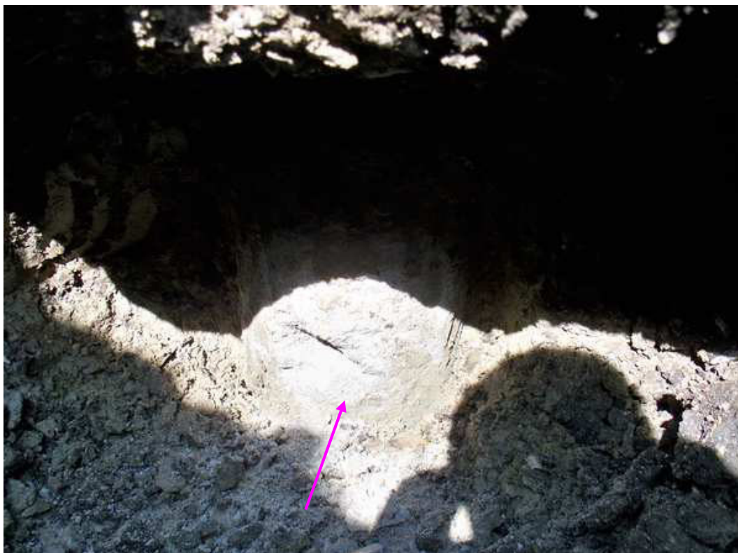
Obr. č. 3 – pohled na zastiženou mikropilotu
